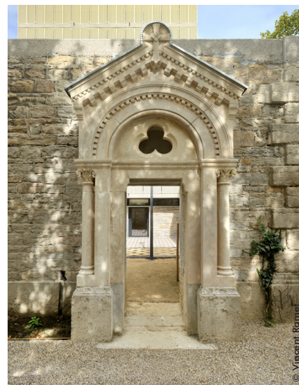
Entrée latérale de la résidence Richelieu Architecte : A-MAS
